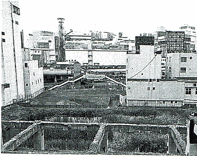
水戸駅前三の丸地区市街地再開発事業区域 現地
